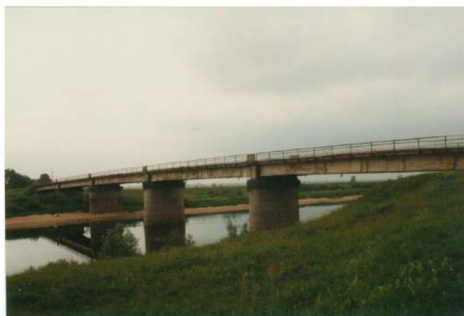
www.Bildarchiv-Ostpreussen.de 022390 / 8-185 Sköpen, Kreis Elchniederung, MT08095-0. Brücke über die Gilge. (1889). ©
