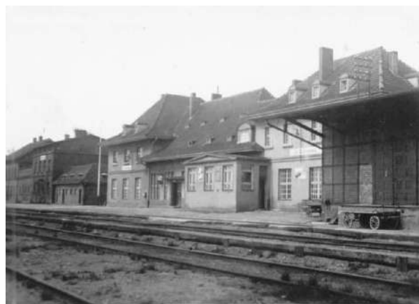
www.Bildarchiv-Ostpreussen.de 009086 / 9-31 Brittanien, Kreis Elchniederung, MT09095-2. 23, Bahnhofgebäude Deutsche Reichsbahn. (1935-1944), ©
