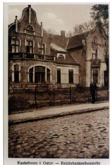
Kaukehnen i. Ostpr. — Reichsbanknebenstelle www.Bildarchiv-Ostpreussen.de 006710 / 121 042 Kuckerneese, Ort, Kreis Elchniederung, MT08095-8. Kuckerneese, Reichsbanknebenstelle vor dem Neubau in der... (1910-1938), ©
