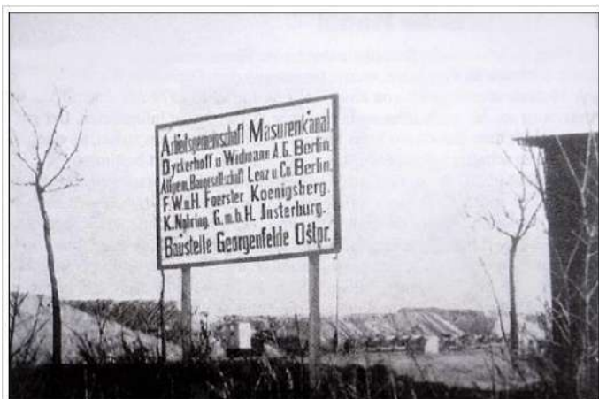
Информационный щит на строительстве шлюза Георгенфельде. 1935 г.
