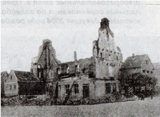
Разборка здания ратуши после пожара 1877 года. Справа видна сохранившаяся пристройка с гарнизонной гауптвахтой
