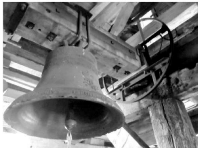
Сохранившаяся в храме старая система крепления колокола с металлическим колесом
